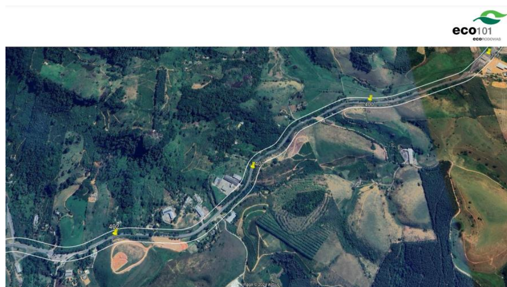
Largura da faixa de domínio entre o Km 399 (Praça do Pedágio) e o Km 402 (acesso a ES 488) é de 40m.
